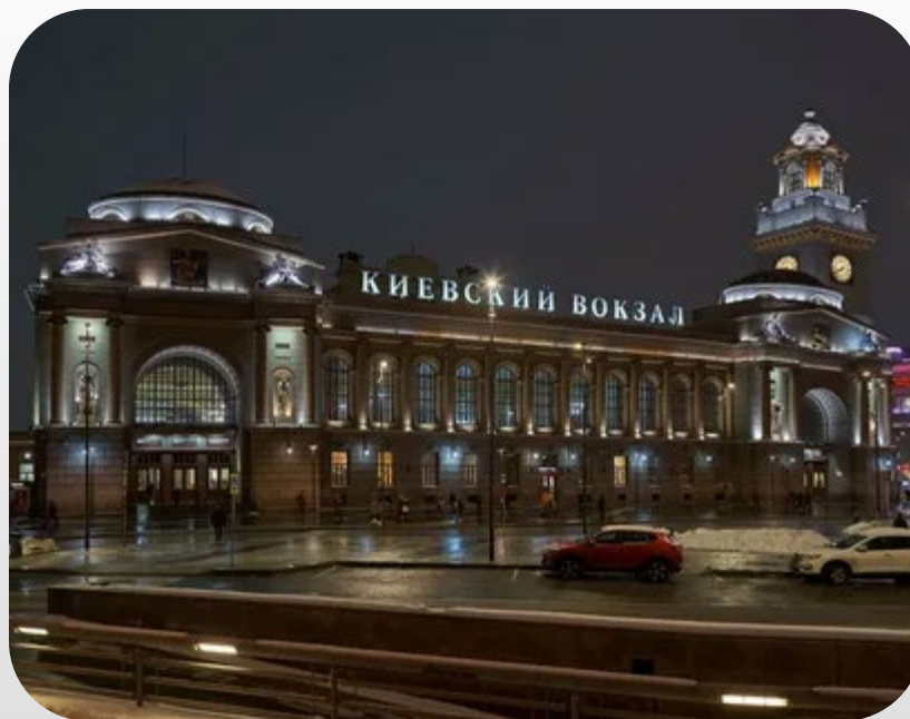
Здание Киевского вокзала
